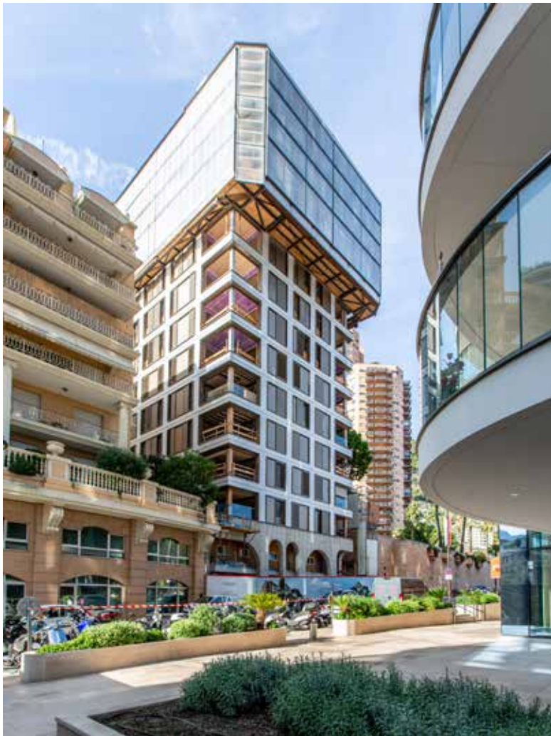
Tour Carmelha en cours de montage à Monaco ©Tomatoki
