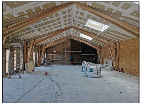
Mise en oeuvre d'enduits épais en terre de site pour la recyclerie et déchèterie en Dombes à Châtillon-sur-Chalaronne 03 © Lieux Fauves
