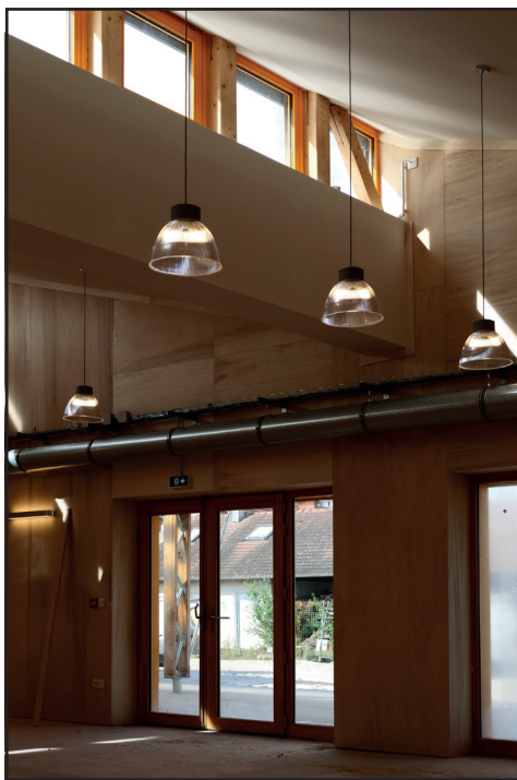
Centre de formation à la construction paille en cours de réalisation ©Vivarchi
