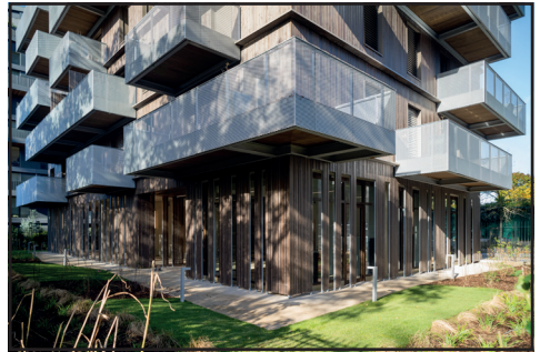
Lot 6 de la ZAC Paul Bourget à Paris, l'un des premiers ouvrages bois avec bardage bois montant à plus de 30 m ©Philippon Kalt
