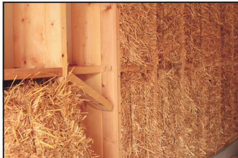
Travaux de Garnissage des panneaux, ferme du rail, paris 19 ©Grand Huit
