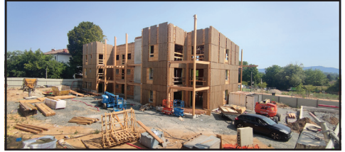
Origine Trévoux, 84 logements en cours de construction à Trévoux 02 ©CBS-Lifteam
