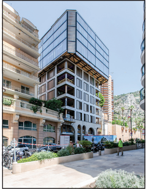
Villa Carmelha, Monaco - Studio Bellecour - BELLECOUR Architectes ©Tomatoki
