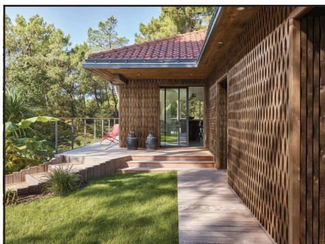
Bardage en tasseaux RythmixOndes par ISB ©Midisix
