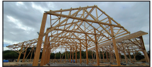
Plateforme stockage bois Quéven © Groupe Egis
