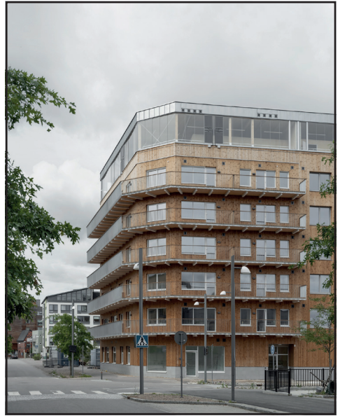
Intervallat : 112 logements intergénérationnels, 100% bois et à énergie positive, à Linköping en Suède ©Johan Dehlin
